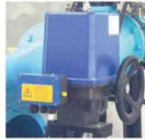
Fig. 5. Actuatorul, respectiv vana de intrare
