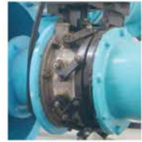
Fig. 5. Actuatorul, respectiv vana de intrare
